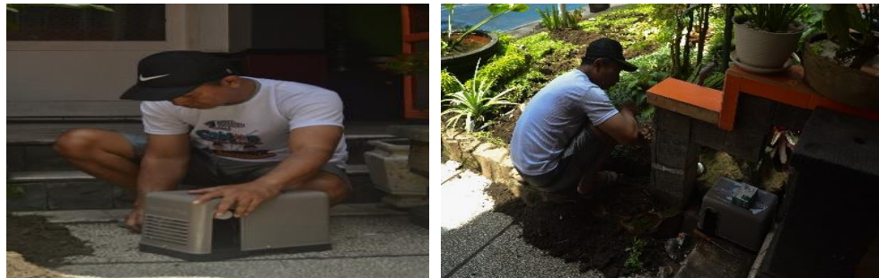
Gambar 7 : Penempatan pompa air
