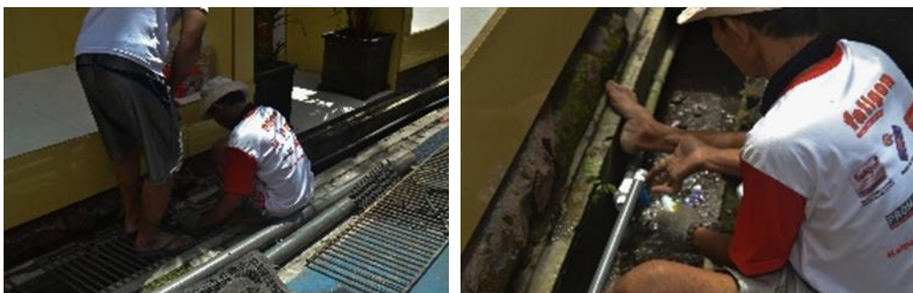
Gambar 5 : Mencari sumber air dan penentuan Pipa air
