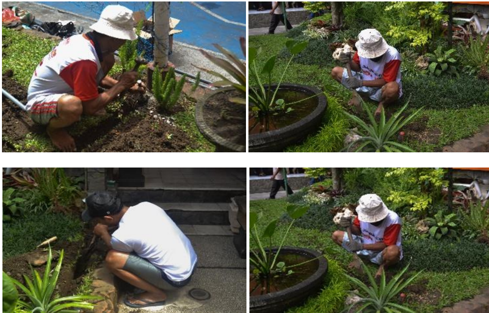
Gambar 8 : Galian Pipa memanjang dan melintang pada Taman (6x3) m
