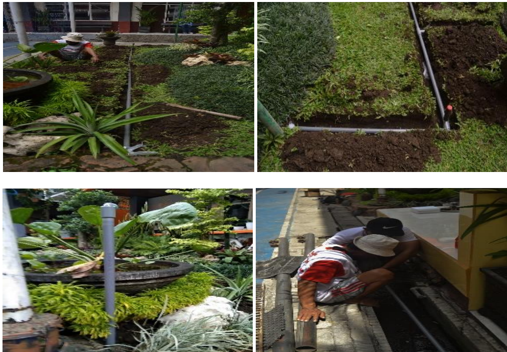
Gambar 9 : Pemasangan pipa irigasi pancar pada taman
